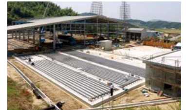
▲整備工事中の施設
