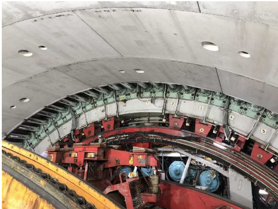
写真1 坑内状況写真(マシン上部)
