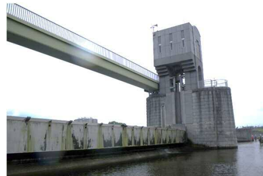
水位調整ゲート (下流より望む)
