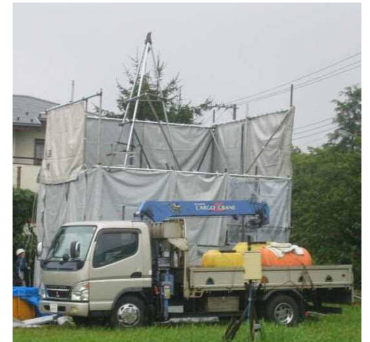
ボーリング調査イメージ
