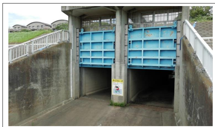
六郷排水樋管開放状況
