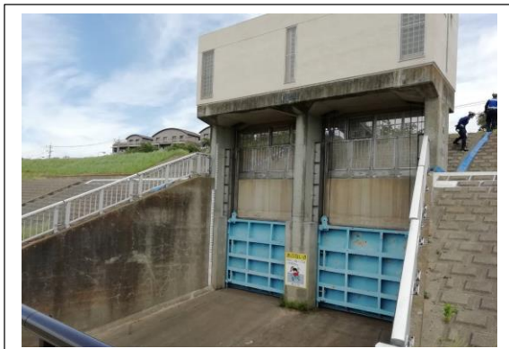
六郷排水樋管閉鎖状況
