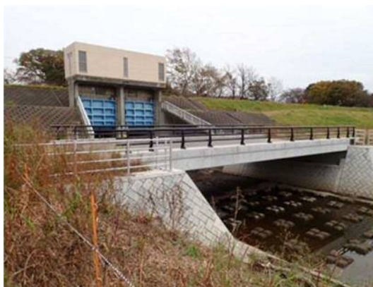
写真 3 六郷排水樋管
