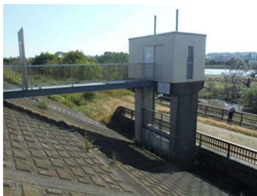
写真 1 猪方排水樋管
