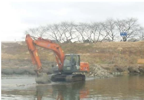
河道内の土砂掘削事例
