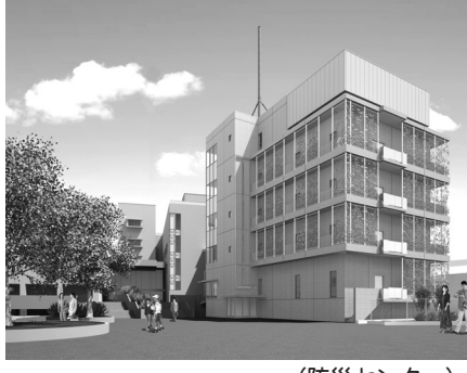
(防災センター)
