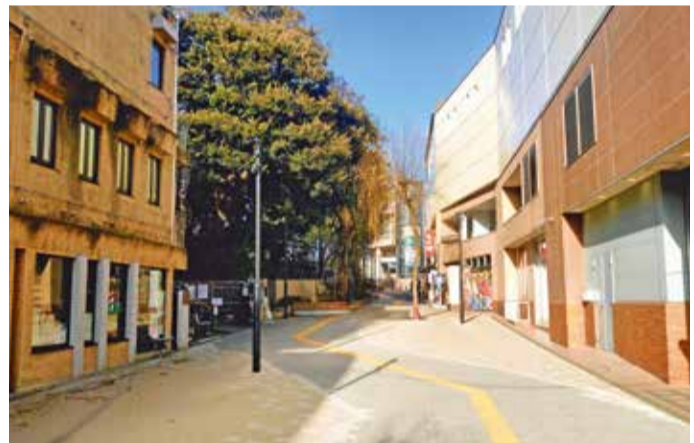
市道改修が完了した道路
