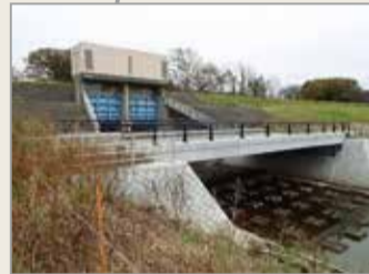
六郷排水樋管
