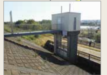
猪方排水樋管
