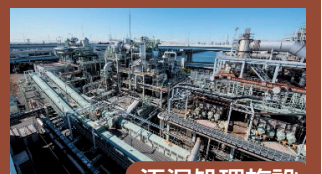
汚泥処理施設
