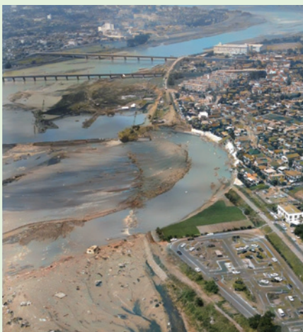
濁流でえぐられた猪方地先(上空から)
