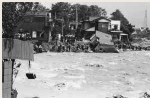
昭和49年の多摩川決壊 河岸侵食により家屋が流出する様子
