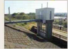
猪方排水樋管
