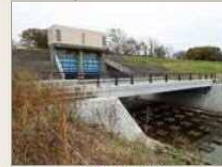
六郷排水樋管
