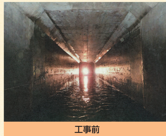
工事前 昭和46（1971）年度に埋設した管内です。
