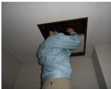
「小屋組・梁」調査の様子
