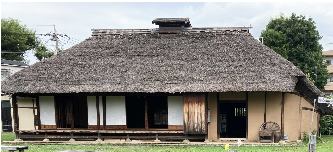
葺き替え工事前の旧荒井家住宅主屋
