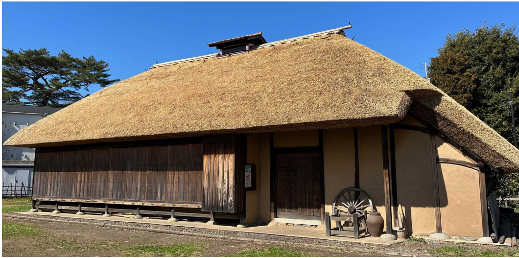
葺き替え工事後の旧荒井家住宅主屋
