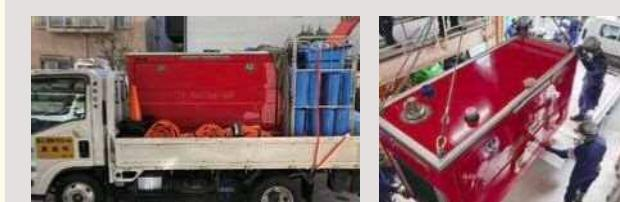
2 排水ポンプを設置し、排水ホース及び油圧ホース等の資機材を接続
