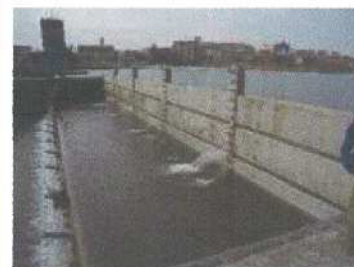
角落しゲート設置
