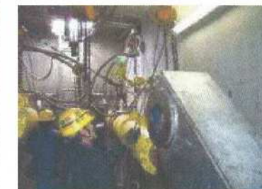
ゲート開閉装置交換 （監査廊内部）
